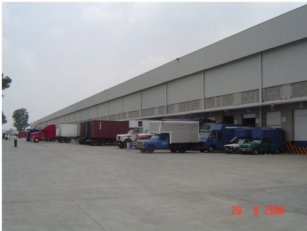
Figura 3.5. Aspecto general de los patios de maniobra exteriores a un almacén
