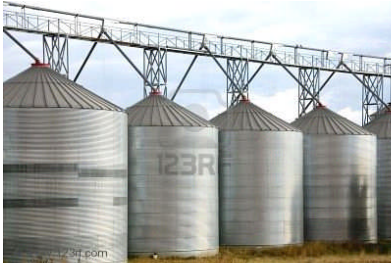
Figura 4.7. Silos de almacenaje de granos agrícolas
